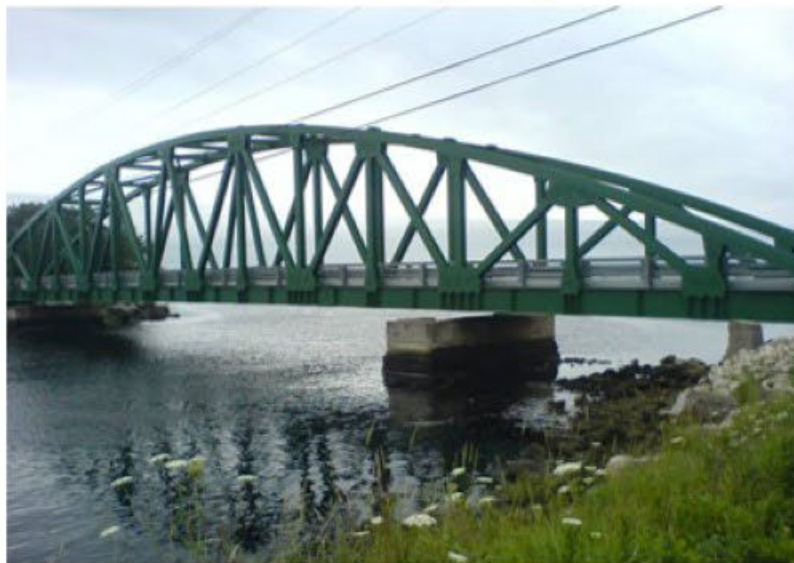
Композитное пролетное строение автодорожного моста пролетом 90м (Канада, Порт-Клайд в Новой Шотландии)
