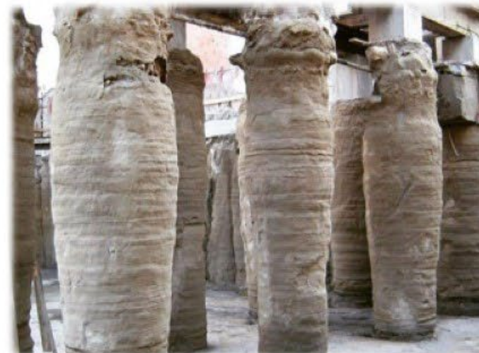
Грунтоцементные сваи после удаления грунта
