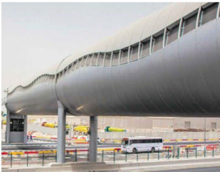
Алюминиевый пешеходный мост «Труба» (Катар, г. Доха)
