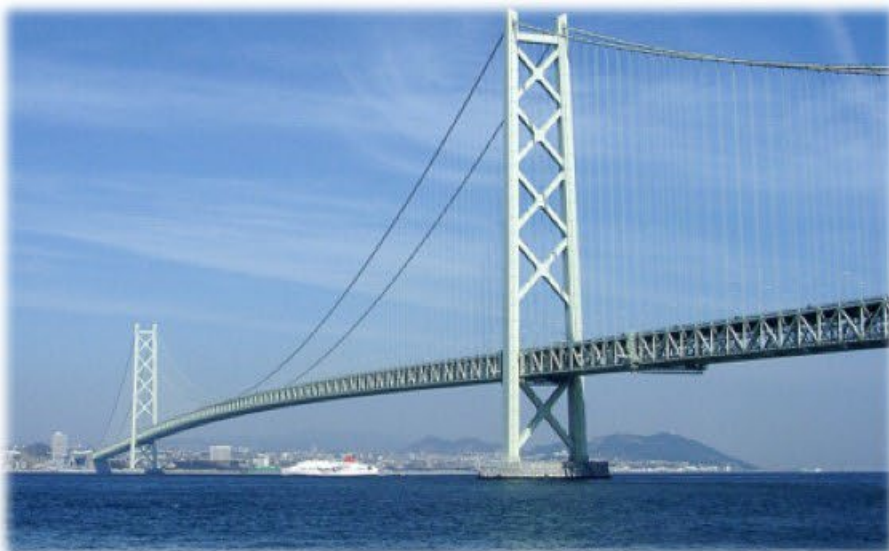
Висячий мост «Акаси-Кайкё» через пролив Акаси, соединяющий острова Хонсю и Сикоку в Японии. Длина главного пролета - 1991 м
