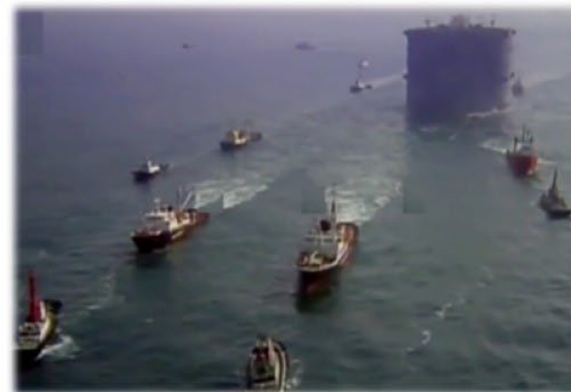
Буксирование по морю кессона опоры моста «Акаси-Кайкё»
