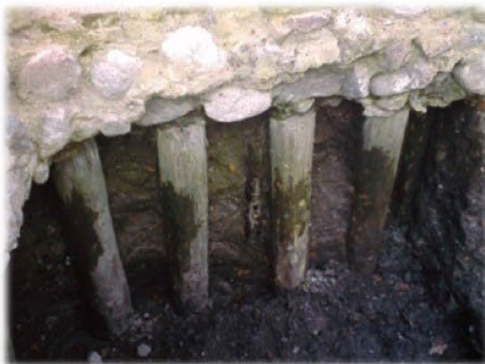
Состояние деревянных свай под домом в Венеции (XVI век н.э.)
