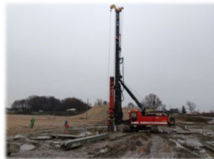
Современная копровая установка
