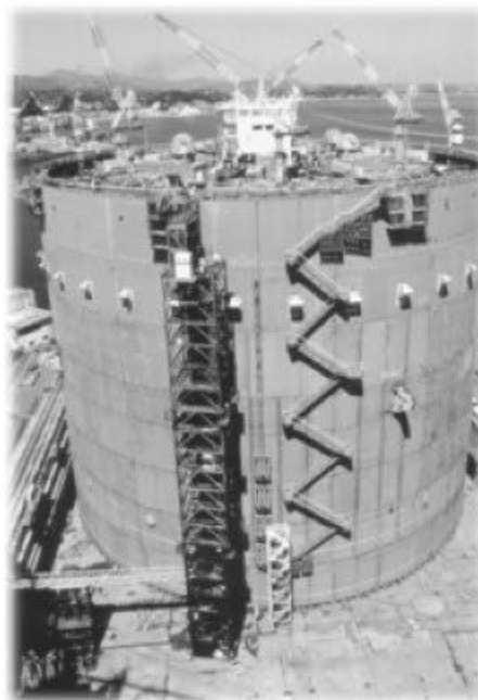
Стальной кессон: Высота – 62м Диаметр – 80м Заглубление в дно – 8м
