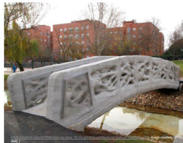
Полностью сборный бетонный пешеходный мост пролетом 12 м, напечатанный на 3D принтере
