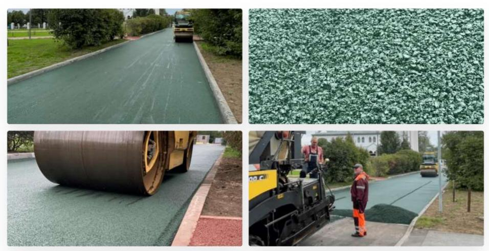
Покрытие из зелёной мелкозернистой асфальтобетонной смеси
