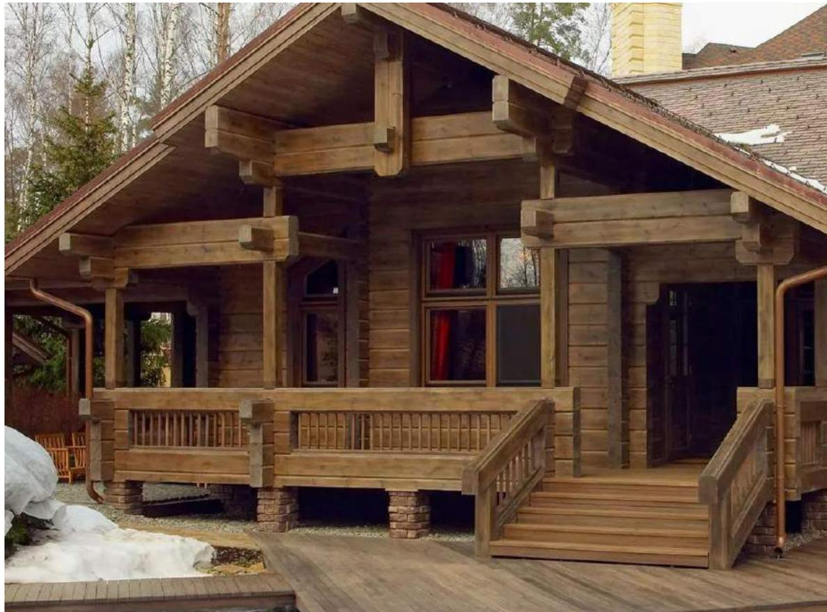
В качестве несущего стенового материала применяется не только клееный брус, но и также клееное бревно и клееное D-бревно. Дом из клееных и D-бревен снаружи выглядит как бревенчатый, а изнутри имеет гладкие стены. Все стеновые материалы, и брус, и бревна обязательно профилируют, таким образом, им придается определенная форма поперечного сечения, при этом профили могут быть разными.
