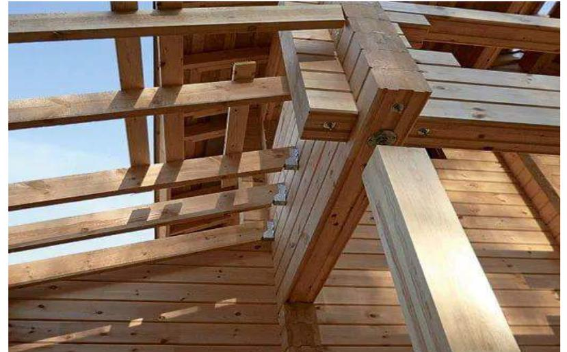
Свойства клееных конструкций позволяют применять их даже при возведении **большепролетных зданий**, и в частности, бассейнов. Клееные балки могут достигать в длину 20 м, обладают достаточной прочностью, чтобы выдерживать нагрузки без установки промежуточных опор. Клееные деревянные материалы менее подвержены разрушению грибками, но всё же, перед монтажом необходимо **обработать клееный брус составом против плесневых грибов**, особенно стыковочные части «пазы-выступы» и торцы.
